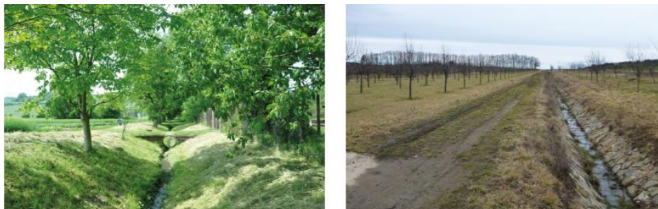
Obrázek 8: Příklad zatravněného příkopu
