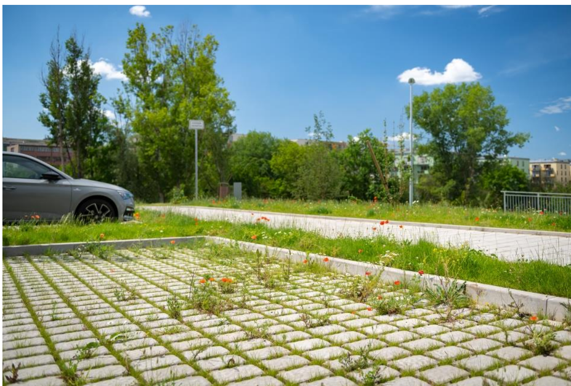
Obrázek 28: Zatravněná dlažba, parkoviště z polopropustného povrchu
